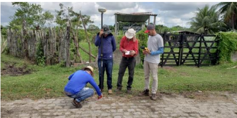
Nivelamento Geométrico (uso do Nível Ótico e Mira com nível de cantoneira)
